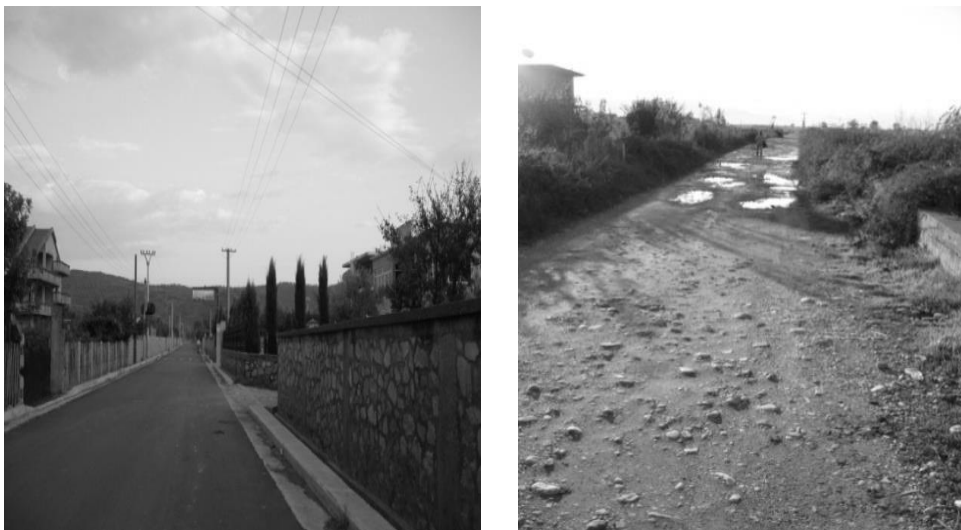
Foto 1. Rrugë të asfaltuara dhe të paasfaltuara në NJ.A Rrethinat (D.Rustja).
